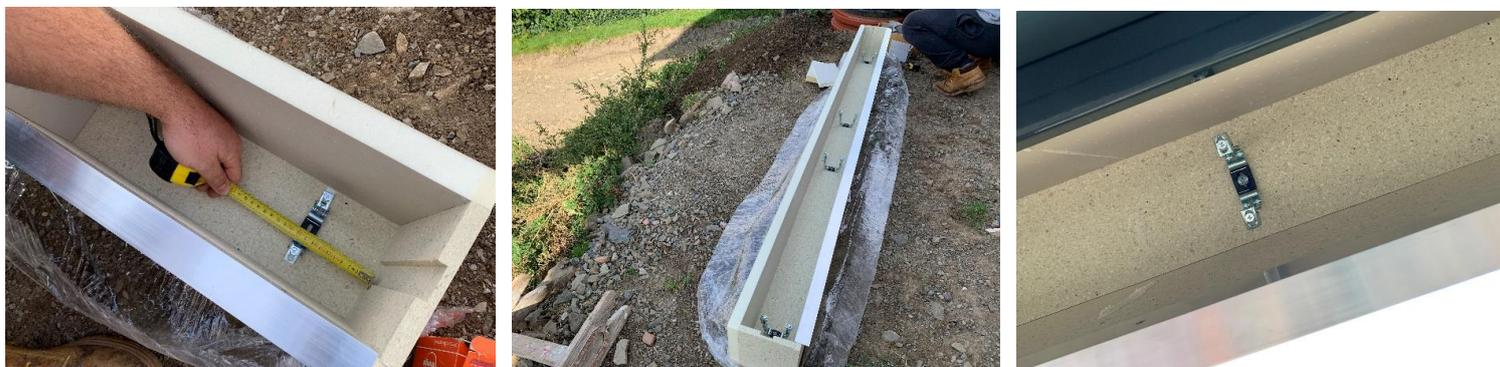
2. Mettre le store dans les douilles au niveau des supports et fixer.
