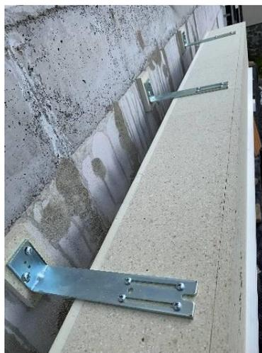
**5. Contrôler l'alignement du box par le niveau à bulle.**
