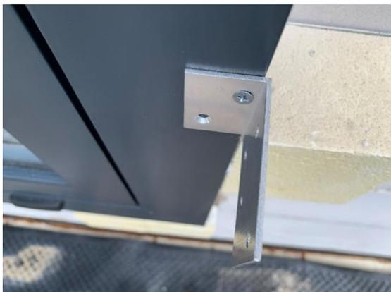
3. On pose l'enveloppe sur le châssis de sorte qu'elle touche les cornières et on la fixe par les vis. On fixe la douille de l'enveloppe à l'intérieur du box et l'enveloppe à travers les cornières.
